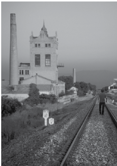
3. Torre alcoholera rehabilitada como estudio de arquitectura desde 1986. Fábrica de azúcar San Isidro en la vega de Granada.
