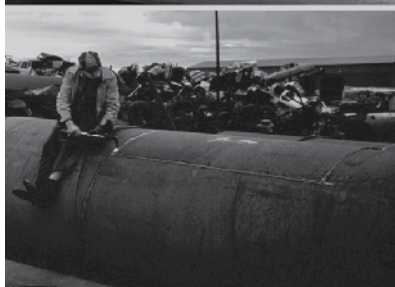
2. Probadores de ropa. Tuberías de acero cortén encontradas en una chatarrería.
